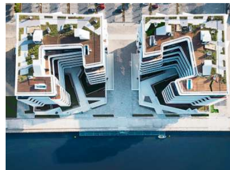
„Wave“. In zwei Wohnhäusern sind an der Stralauer Allee seit 2017 insgesamt 161 Wohnungen und Penthouses entstanden. Foto: BETTR GmbH/Bauwerk Capital GmbH & Co. KG
