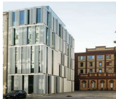
Das Atelierhaus Pfefferberg. Foto: Justus Pysall, Pysall Architekten
