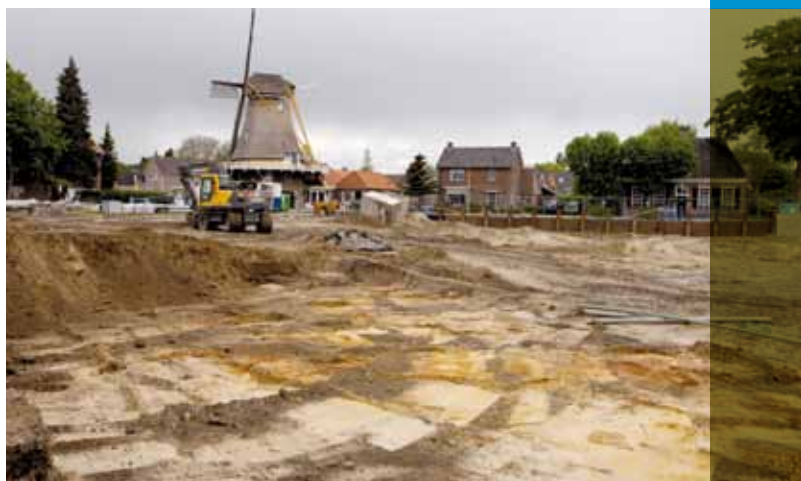
Werkzaamheden fase 1 Waterfront.
